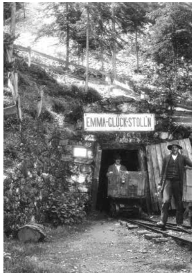
Bergwerk Ankerschlag, Stolleneingang, Foto: Hans Hauser
